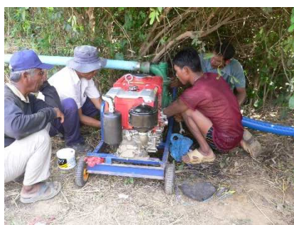
揚水ポンプの据え付け作業
